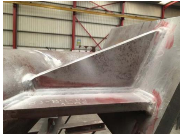
Essais Test non destructifs et essais
