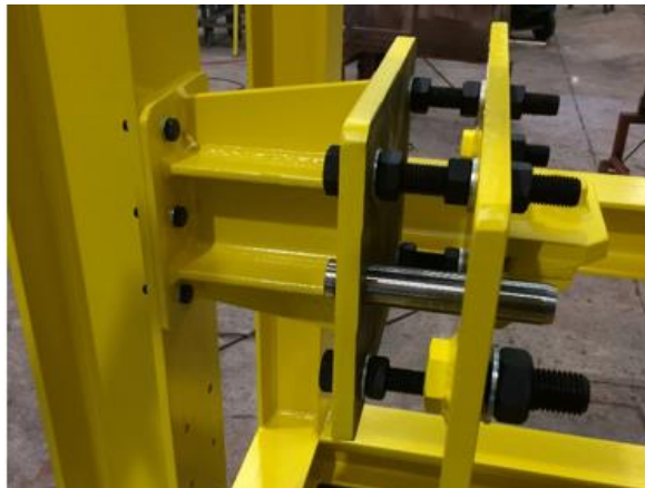
Uniones atornilladas Pre-montaje
